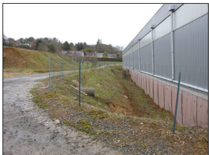
Zone devant accueillir le stockage N°5
