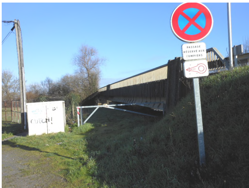
Aire réservée aux secours pour pompage dans l'Oust à 100 mètres au nord du site
