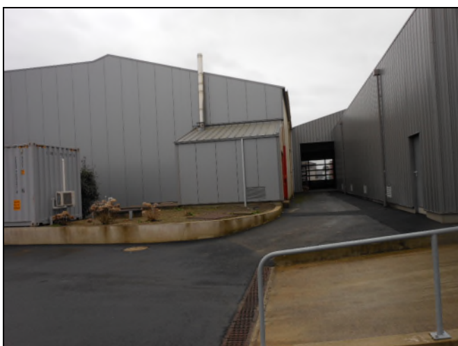
Vue générale des bâtiments N°1 et N°2
